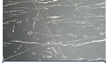
三角広場の床の写真
